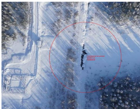
Рисунок 1. Снимок подозрения на разлив трубопровода при облёте БПЛА
